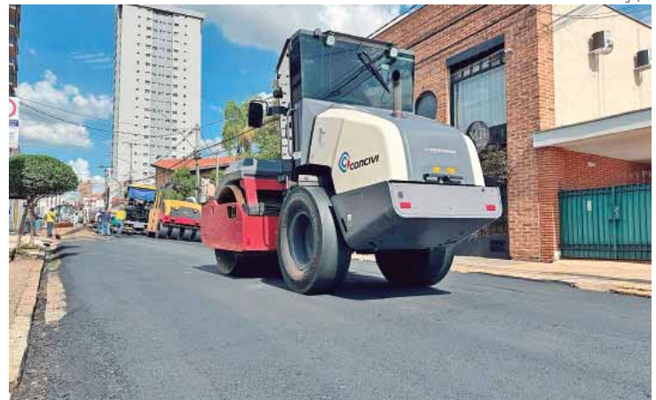
Serviços na Dom Pedro I incluíram adequações na drenagem, fresa e nova massa asfáltica
