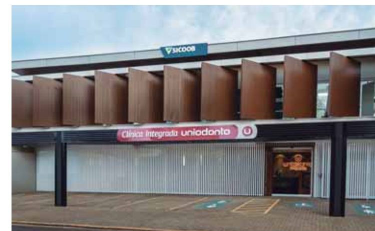
Fachada da nova Clínica
