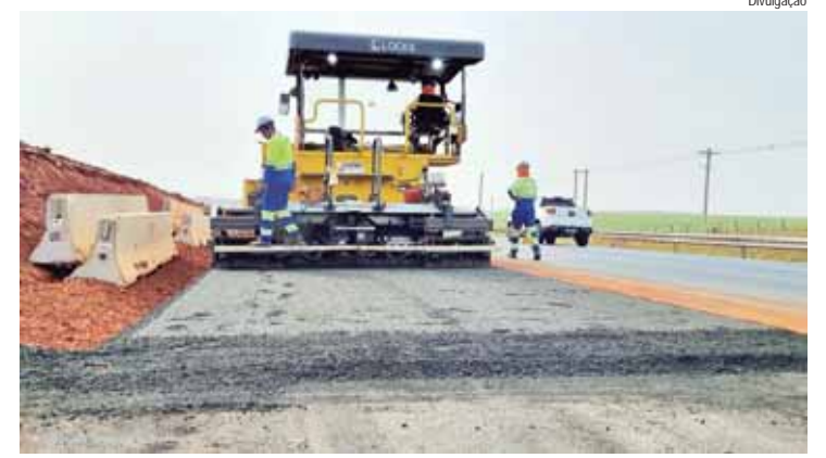
Obra segue acelerada nos trechos de Rio Claro e Cordeirópolis, e liberação da nova pista deve ocorrer em breve
