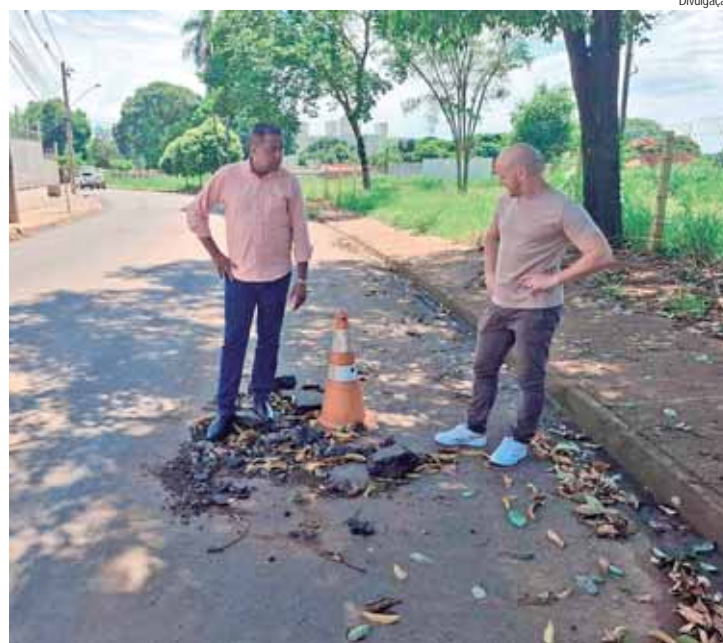
Vereador Thiago Ribeiro (PRD) esteve no bairro Santa Rita para acompanhar de perto as condições da infraestrutura local
