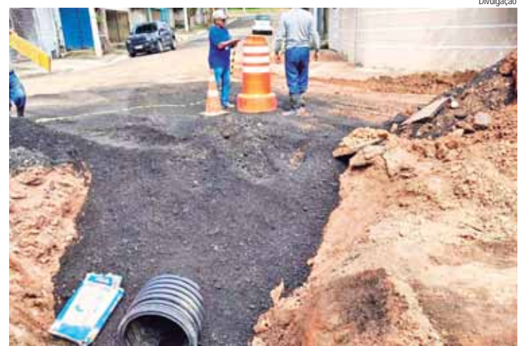
Obra consiste na instalação de tubulação de tamanho adequado para garantir escoamento de água que elimine os transtornos causados pelo acúmulo de água na via
