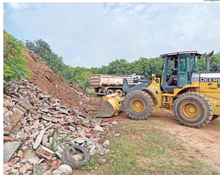
Central de Obras recebeu resíduos de forma indevida na gestão passada e passa por limpeza
