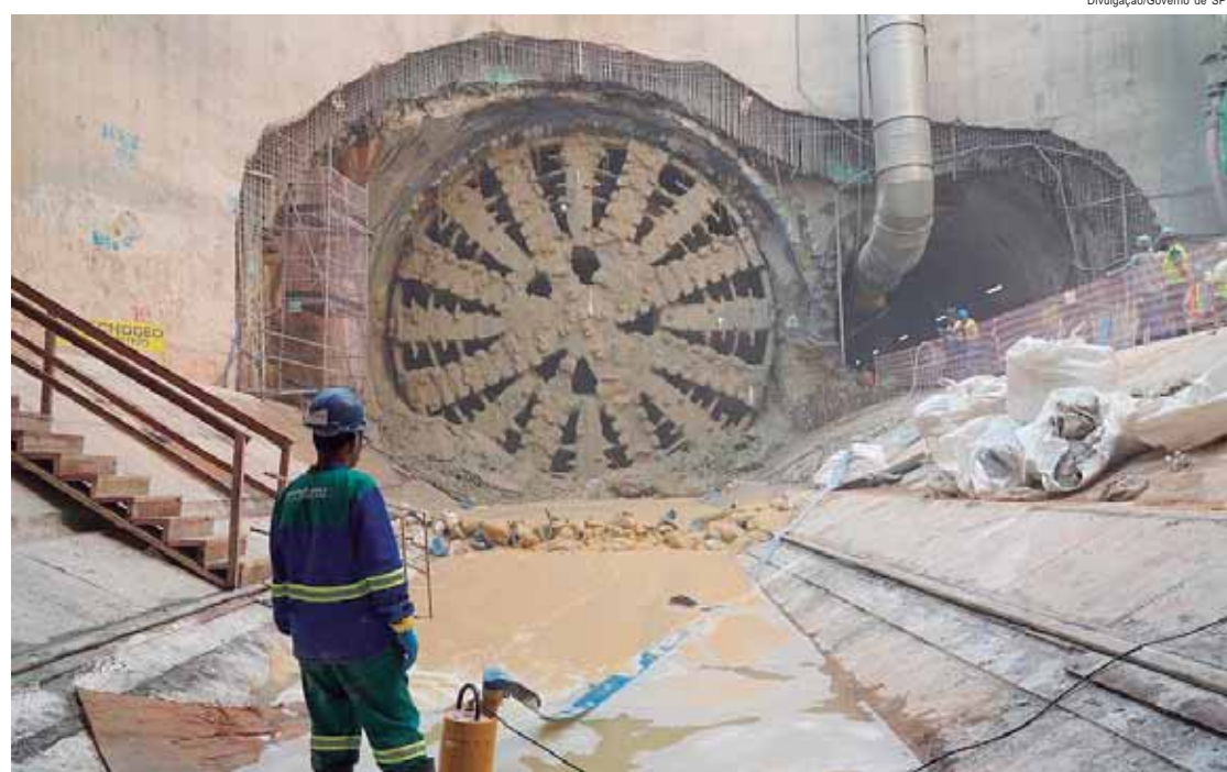
Obras do tatuzão na Linha 2 - Verde do Metrô; orçamento contempla Trem Intercidades Campinas - São Paulo
