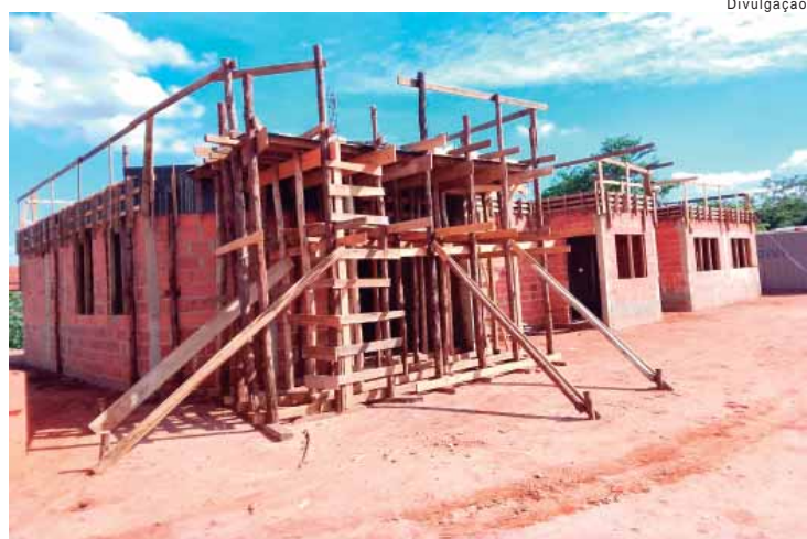
Outras obras fruto de convênio estão em andamento, como a construção do CEO e da piscina semiolímpica
