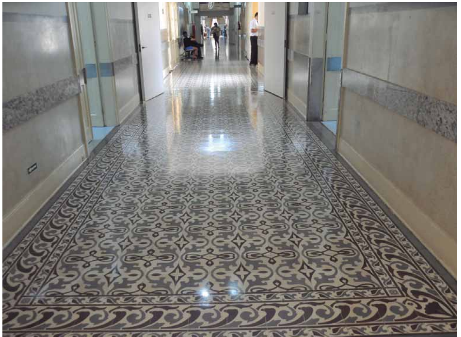
Devido à grande superfície a ser revestida, a Santa Casa montou uma fábrica de ladrilhos e mosaicos, adquirindo para isso uma prensa apropriada para a produção de pisos
