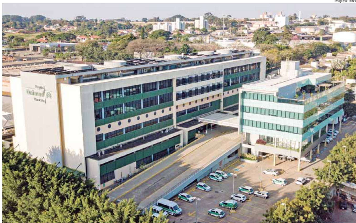
Hospital Unimed Piracicaba e Centro Administrativo da Cooperativa
