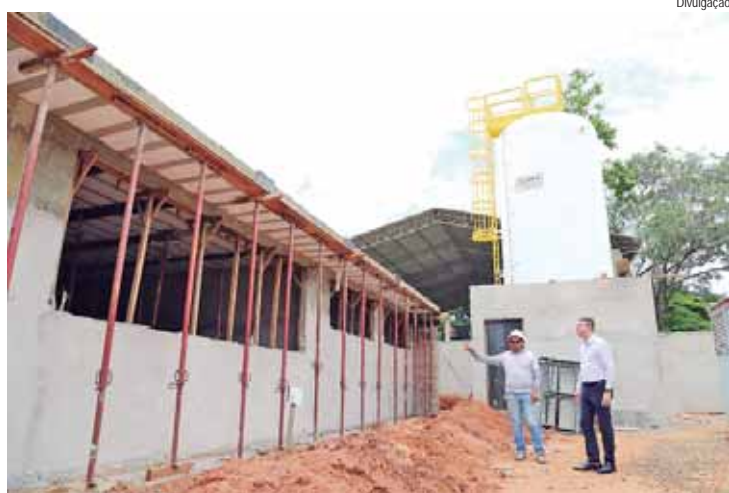
O secretário municipal de Educação, Bruno Roza, vistoriou as obras de duas novas escolas
