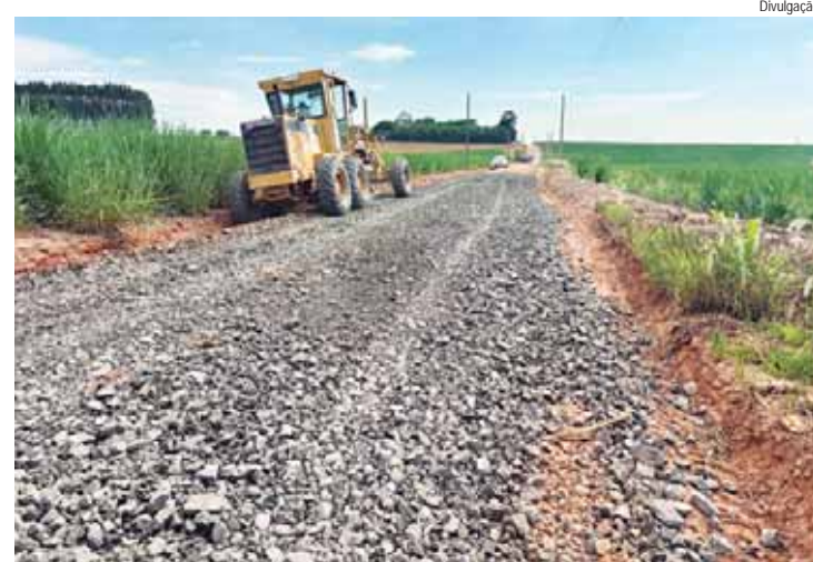
Aplicação de lajão britado na estrada Antonio Dias Rodrigues
