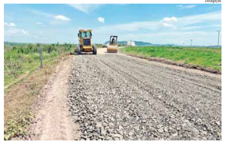
Manutenção da estrada Francisca Domingues Detoni no bairro Dini
