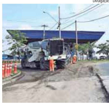
Rua Zulmira do Vale, na região do São Jorge, será pavimentada com concreto
