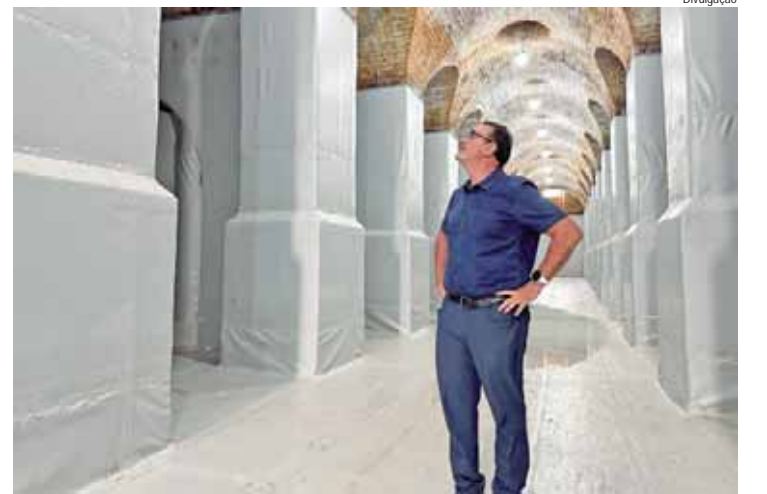
Reservatório principal já está pronto e vai passar agora por testes de estanqueidade
