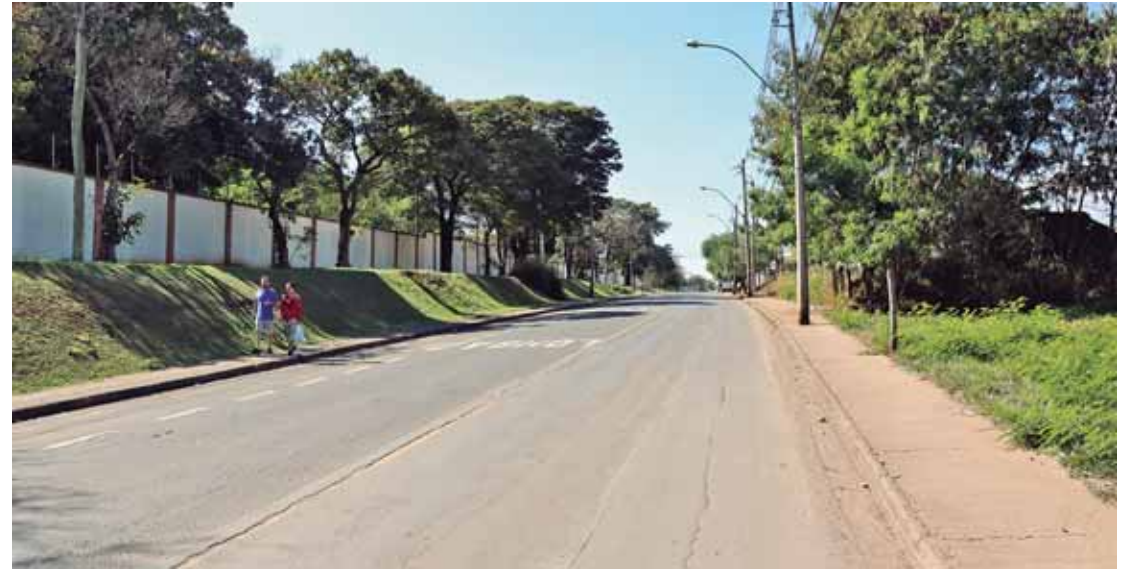
Avenida Laranjal Paulista, no Campestre, receberá nova pavimentação asfáltica
