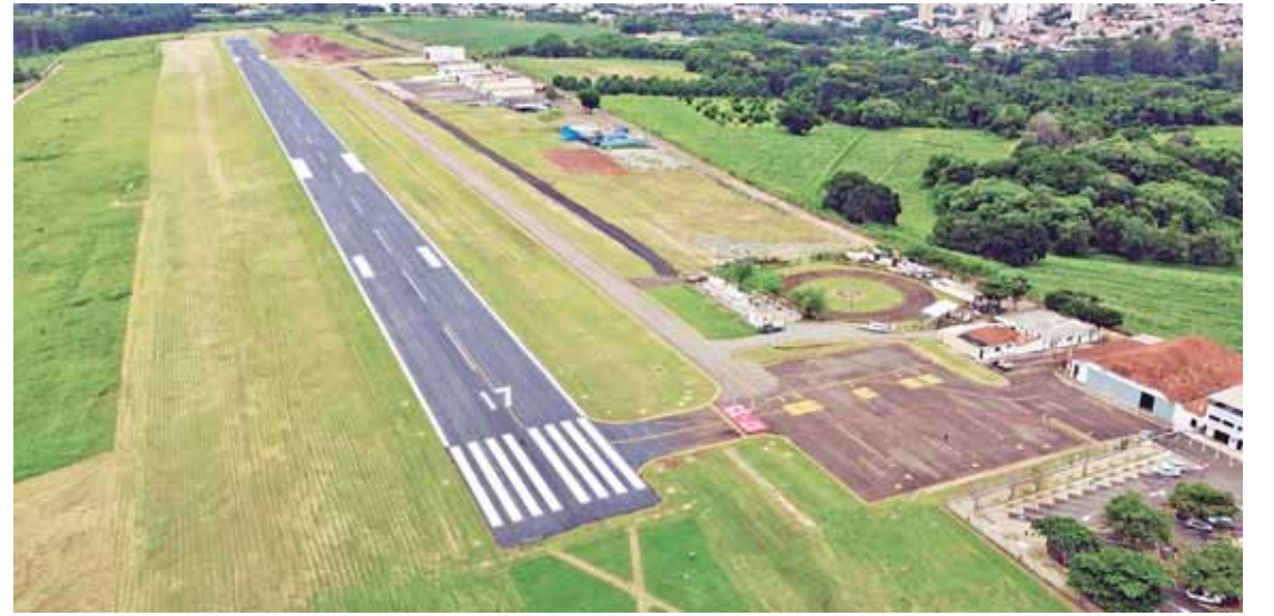
Aeroporto municipal Pedro Morgante receberá reforma total do prédio administrativo e ganhará uma guarita
