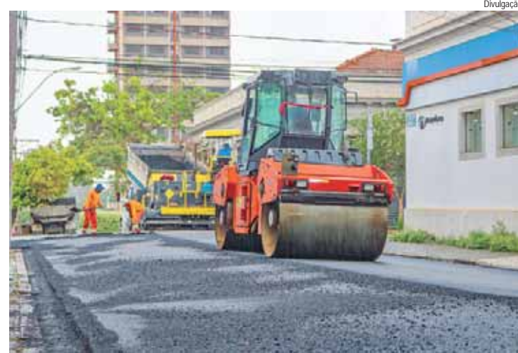
Recape asfáltico na rua Alferes José Caetano, na região central
