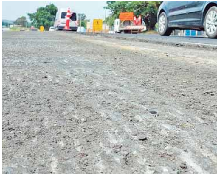
Será realizado trabalhos para restauração do pavimento no retorno do km 5+300
