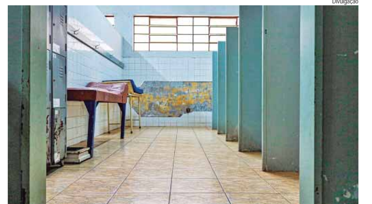
As reformas dos sanitários e vestiários tem valor de R$ 362 mil
