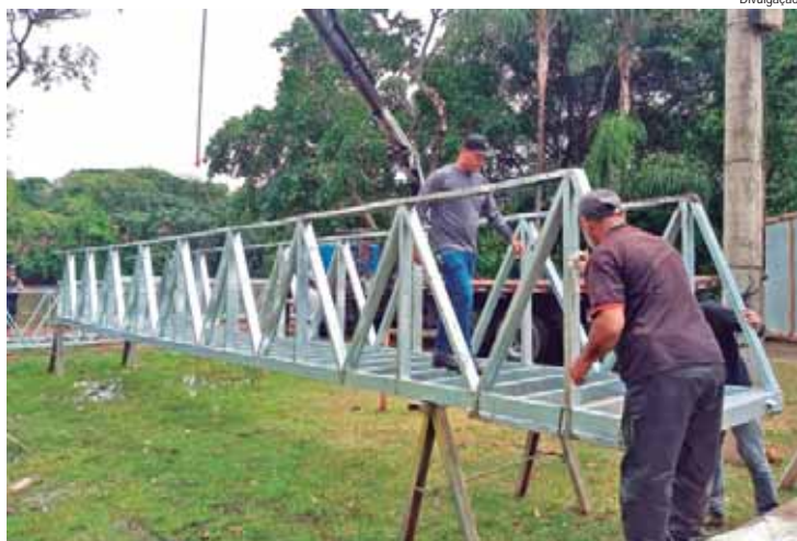
A estrutura, agora em aço metálico, tem as mesmas medidas do pier anterior
