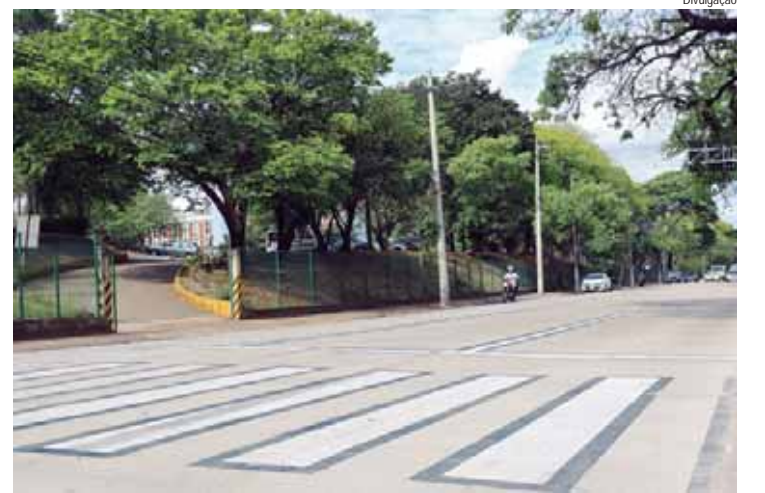
Prefeitura concluiu pavimentação em concreto na avenida Limeira
