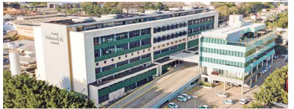
Hospital Unimed Piracicaba e Centro Administrativo da Cooperativa
