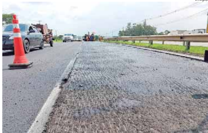
Trabalhos ocorrem no retorno do km 5+300 para a restauração do pavimento
