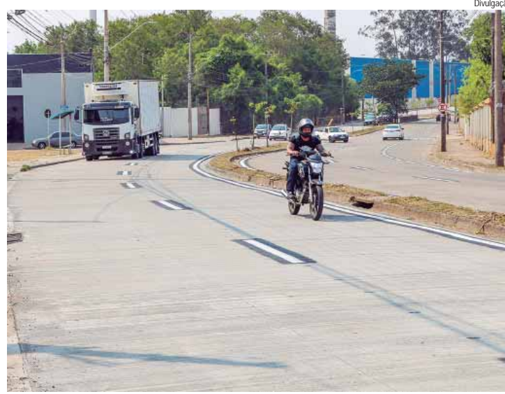
Via recebeu concreto da avenida Investigador Lucídio Leite até a saída para a rodovia SP-304
