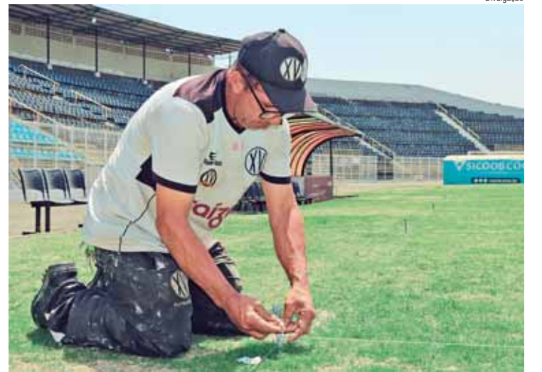
O funcionário Jaime Andrade Júnior faz as marcações que serão usadas para regular os pontos de iluminação
