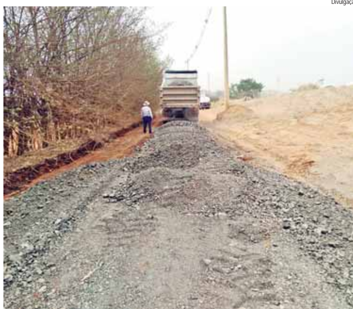
Manutenção na estrada PIR 017L, no bairro Tupi
