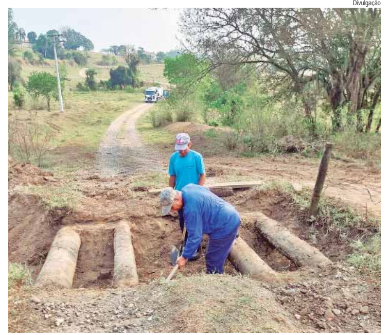
Equipe da Sema realizando a manutenção de um mata-burro no bairro Pessatinho
