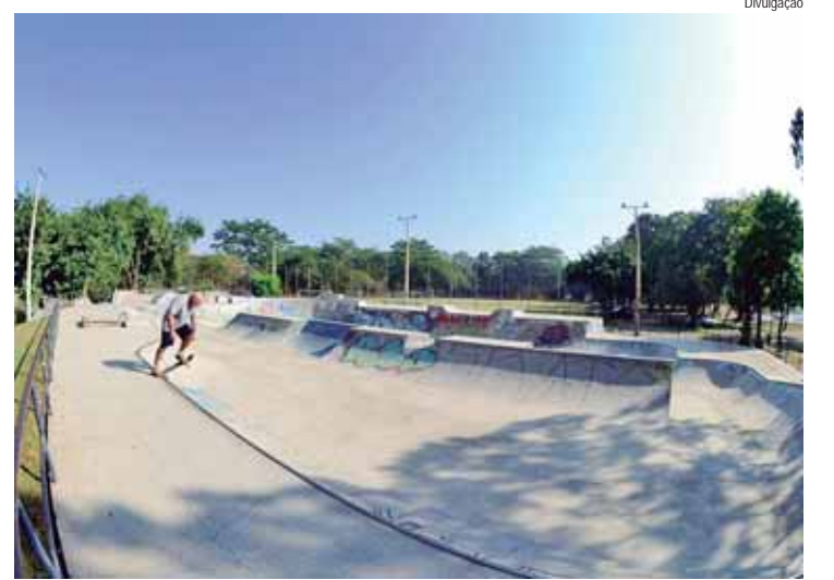
As obras na Área de Lazer do Trabalhador tem valor estimado em R$ 1.179.153,90
