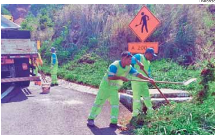
Trecho entre Torrinha e Santa Maria da Serra irá operar no sistema Pare e Siga das 7h às 17h para serviços de conservação
