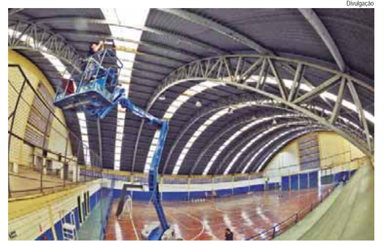
Trabalhador executa a troca do sistema de iluminação do Ginásio de Santa Terezinha
