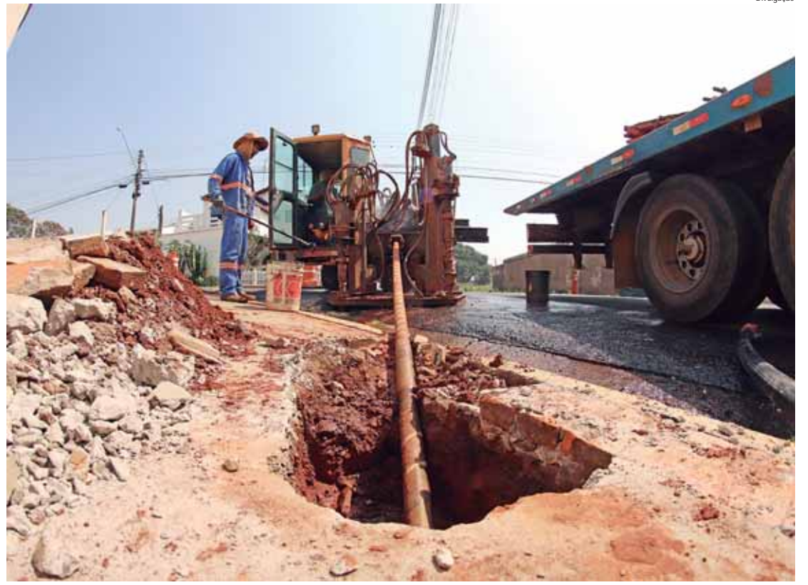
Parte da rede principal de distribuição de água dos bairros está sendo substituída
