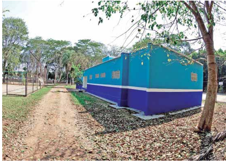
Entregue a reforma dos vestiários da Área de Lazer do Trabalhador
