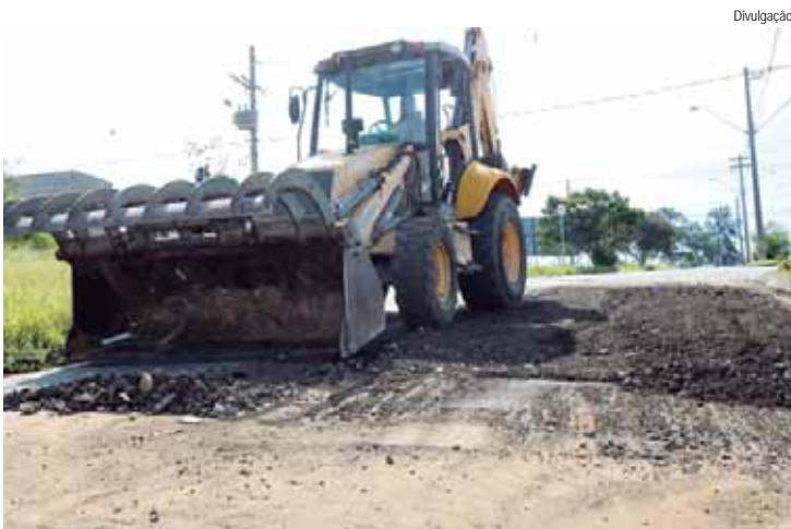
Como medida paliativa, a Semozel vai retirar o asfalto deteriorado e eliminar buracos
