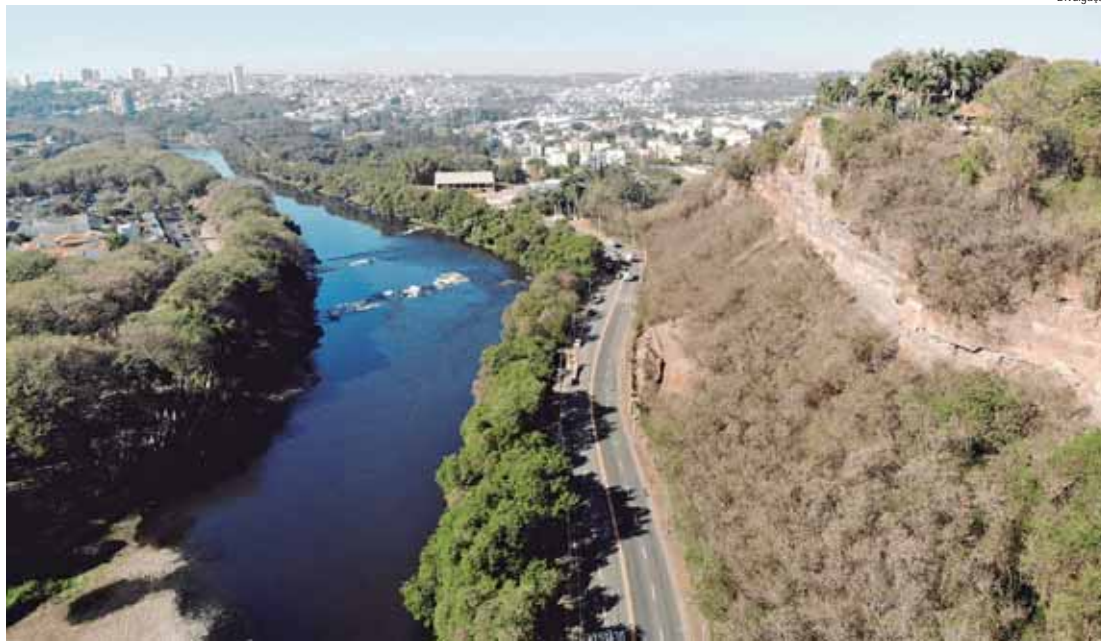
A avenida Jaime Pereira, conhecida como Estrada do Bongue, foi liberada totalmente para o tráfego de veículos perto das 12h de ontem (7)
