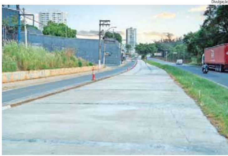
Com sede em Itatiba, a Jofege fez acordo para fornecer a pavimentação em concreto em Piracicaba
