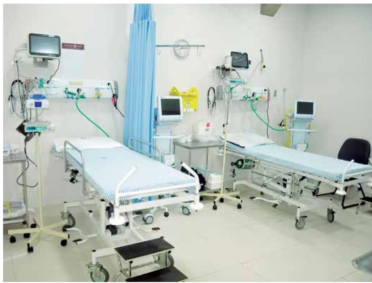
Sala urgência e emergência com leito semi-intensivo
