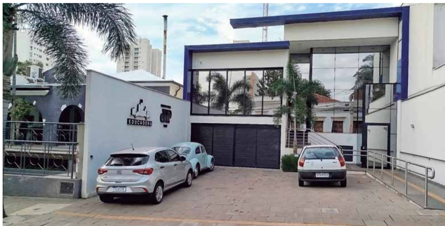
Inaugurada em 2018, nova sede, na rua São José, foi projetada e construída para receber a Rádio Educadora.
