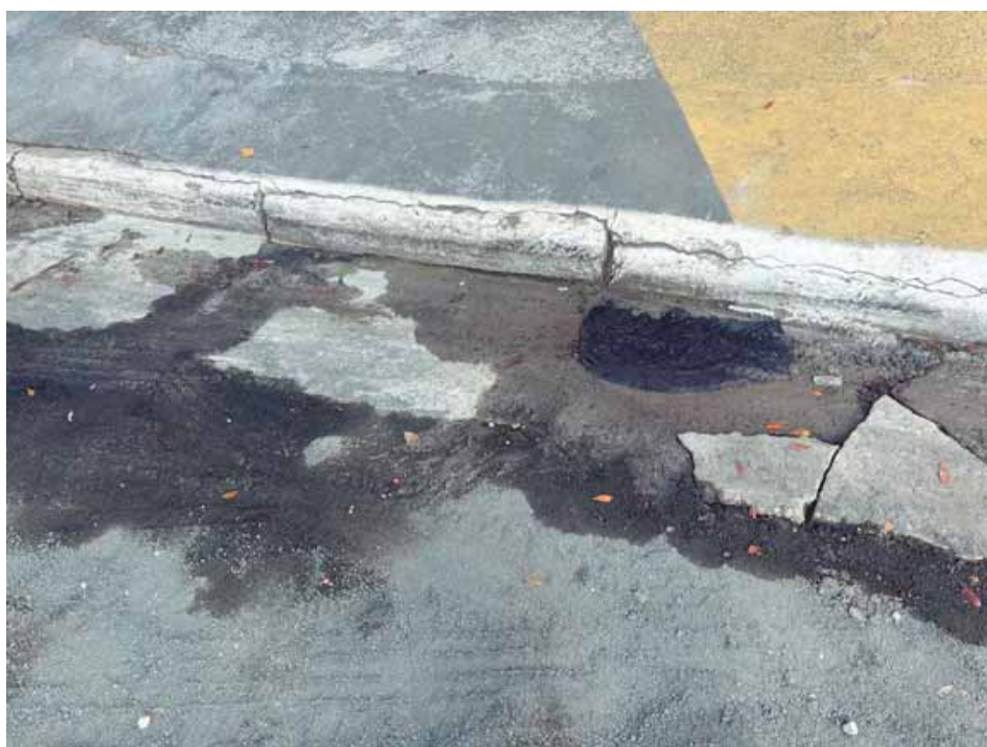
No local, há sinais de vazamento de esgoto e muito mau cheiro: providências
