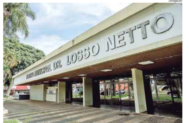
Obras de reforma serão na parte externa e interna do Teatro Municipal Dr. Losso
