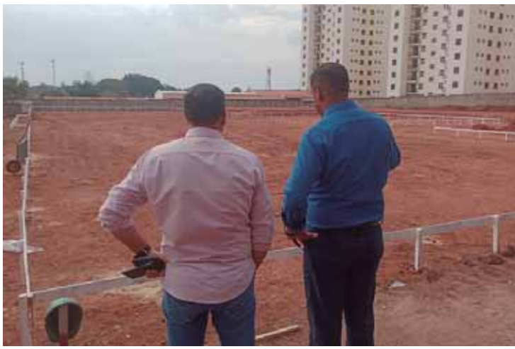
Thiago Ribeiro esteve no canteiro de obras nesta quinta-feira (4)
