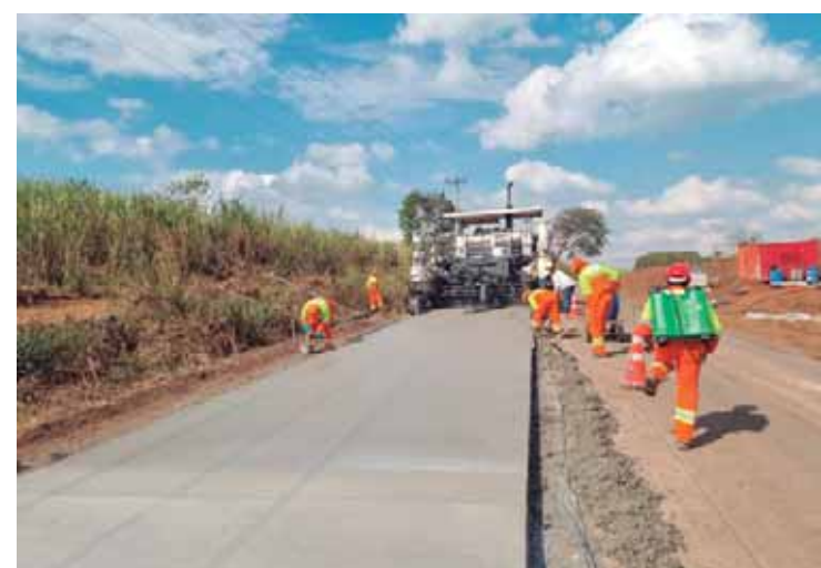
Prefeitura segue com os serviços de pavimentação em concreto no antigo Anel Viário Municipal Comendador Leopoldo Dedini
