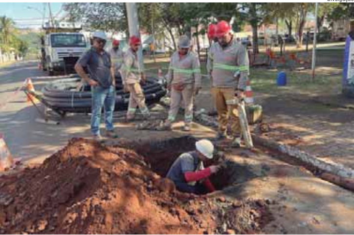
Equipamento chamado de "tatuquinho" é usado para fazer a perfuração e instalação dos canos
