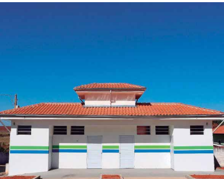
Os banheiros da Praça do Idoso também serão inaugurados
