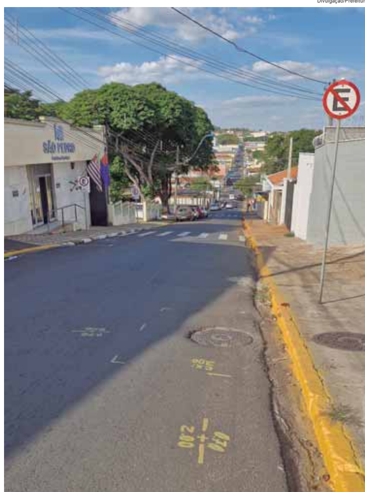
Empresa já fez as marcações na rua Valentim Amaral para dar início às obras
