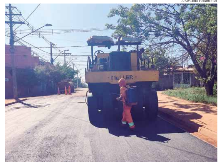
Obras de pavimentação na Rua Antônio Franco de Lima seguem em ritmo acelerado
