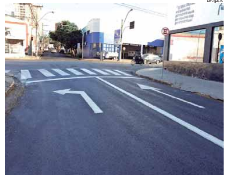
Foram realizados serviços de sinalização horizontal e vertical em duas avenidas e 23 ruas
