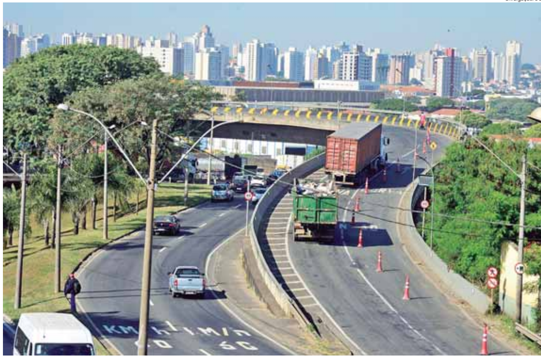
Recape asfáltico será feito no feriado prolongado no viaduto Francisco Jesuino Avanzi (Chicão)
