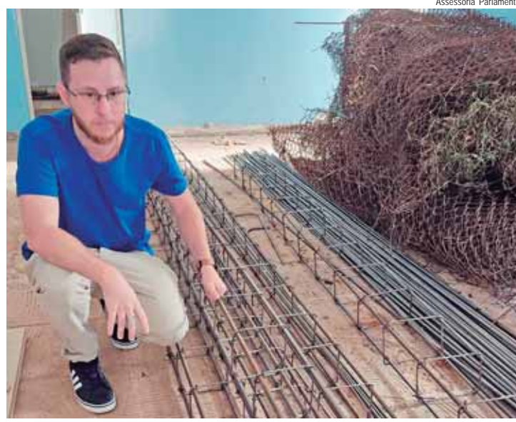
Unidade passa por reforma e vai receber novo muro
