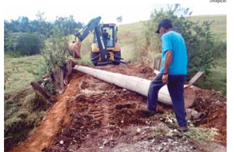
Manutenção em ponte na estrada José Saul Chinelato
