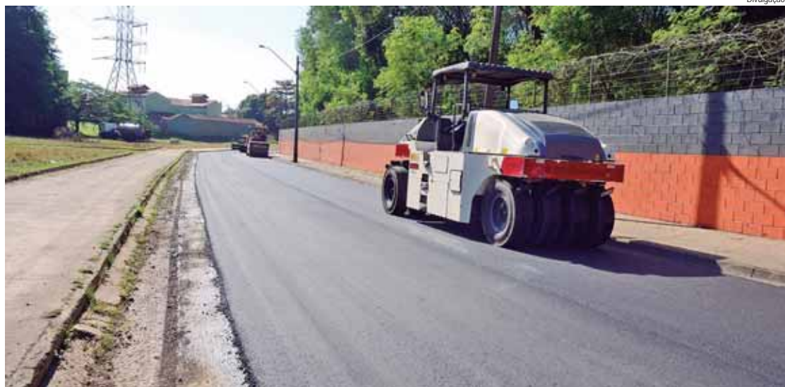
No bairro Nossa Senhora de Fátima, a equipe atua com fresagem e recomposição na rua Jules Rimet
