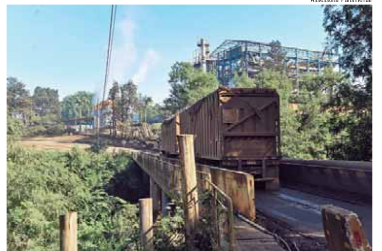
Esgoto a céu aberto, ruas sem asfalto, falta de água e iluminação, além de outros problemas de estruturas básicas penalizam a população local, alerta o vereador Paraná
