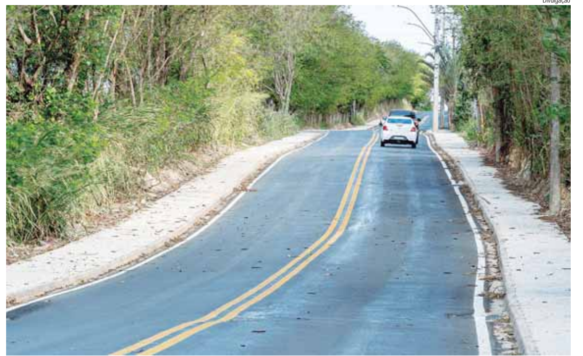
Além do pavimento, foram executadas ainda adequações no sistema de drenagem e calçadas
