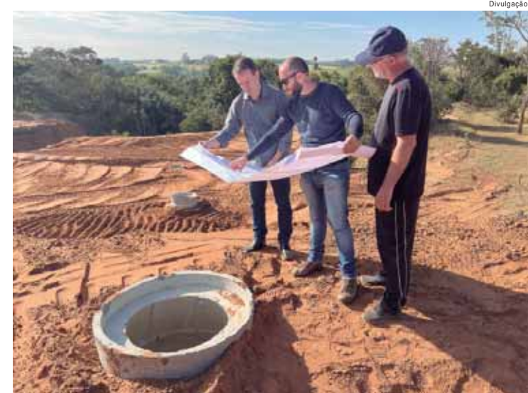
Prefeito Thiago Silva visita as obras no bairro Serra Verde, que tem 429 lotes de mil metros quadrados
