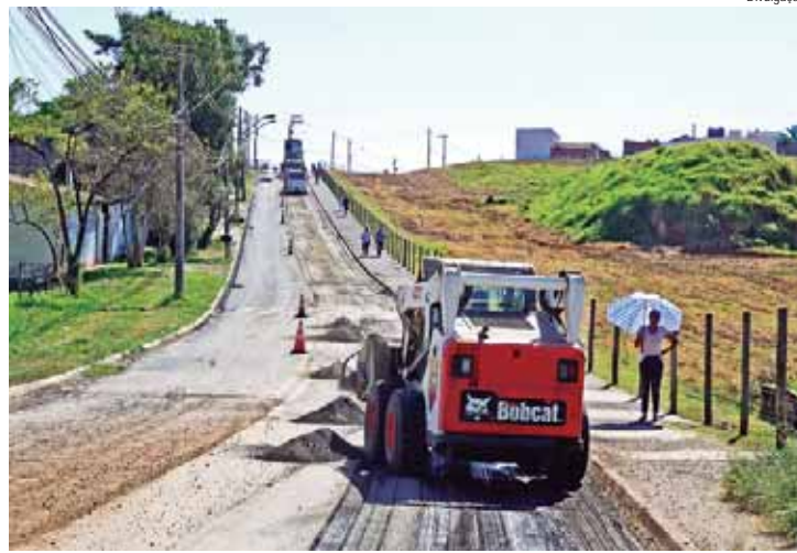
Além do concreto, a via também está recebendo recape asfáltico, no trecho entre o Condomínio Residencial Piracicaba 3 até a rua Ricardo Melotto
