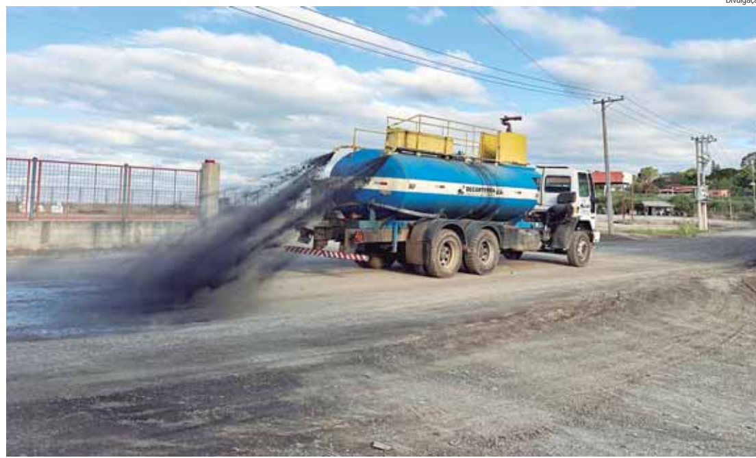
Caminhão aplicando estabilizante na estrada do Canal Torto
