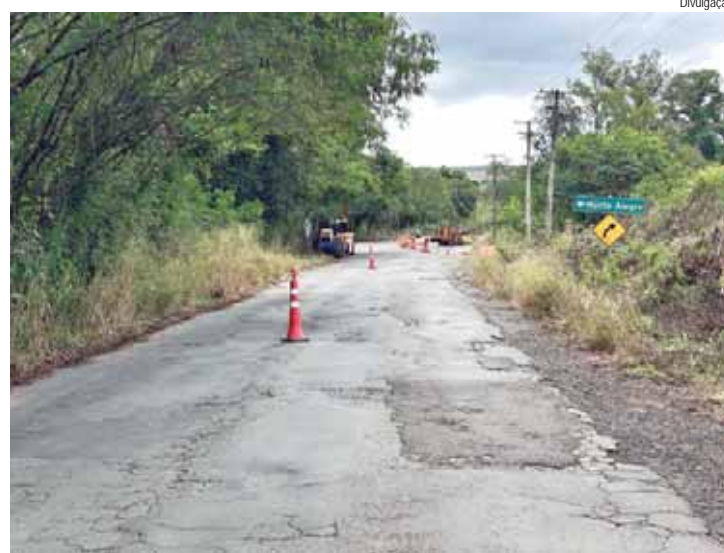
Trecho será pavimentado em concreto em 4,1 km
