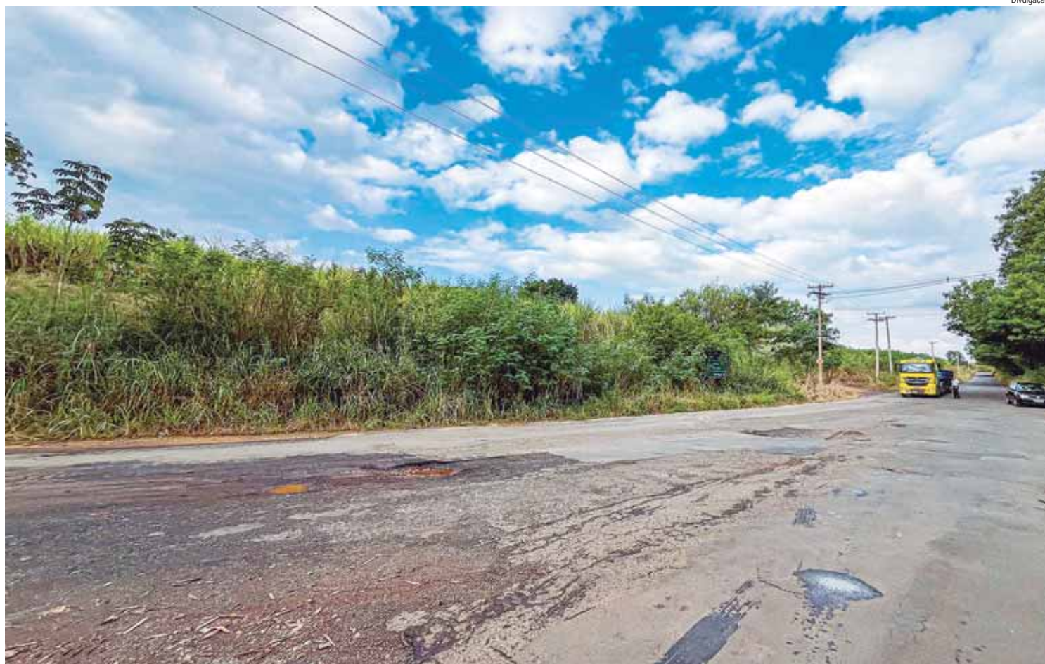
Todo trecho será feito em concreto, em uma extensão de 4,1 km
