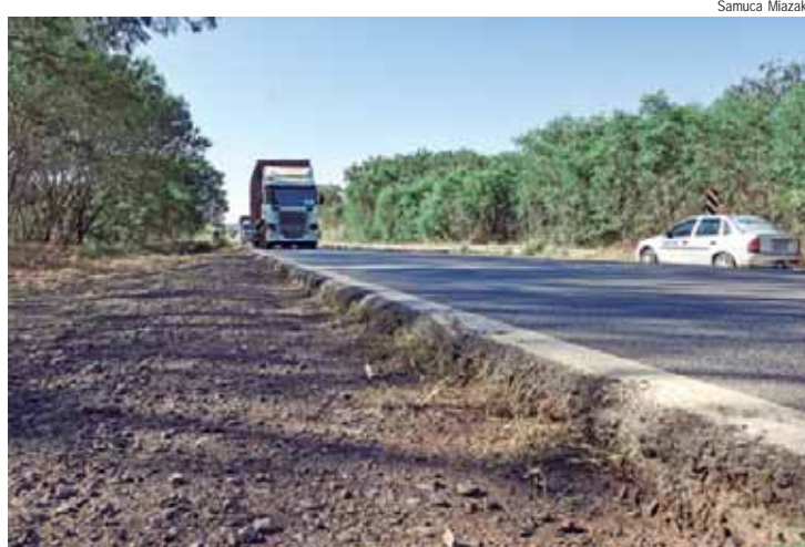
Vereador cobra providências da Prefeitura na recuperação de estrada
