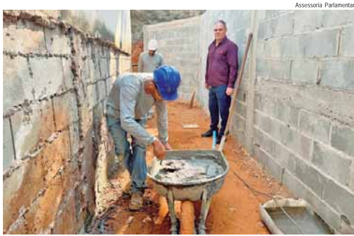
Muro de arrimo está sendo construído no local
