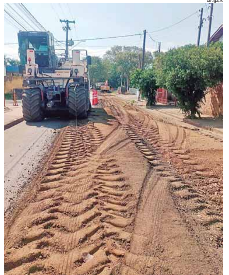
Obras acompanhadas por Josef Borges utilizarão aplicação em concreto do tipo PUC (Pavimento Urbano de Concreto)
