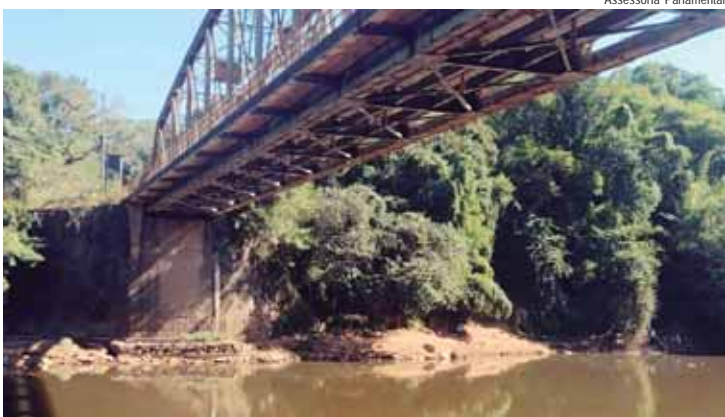
Josef Borges destaca a necessidade de vistorias constantes na preservação da estrutura metálica
