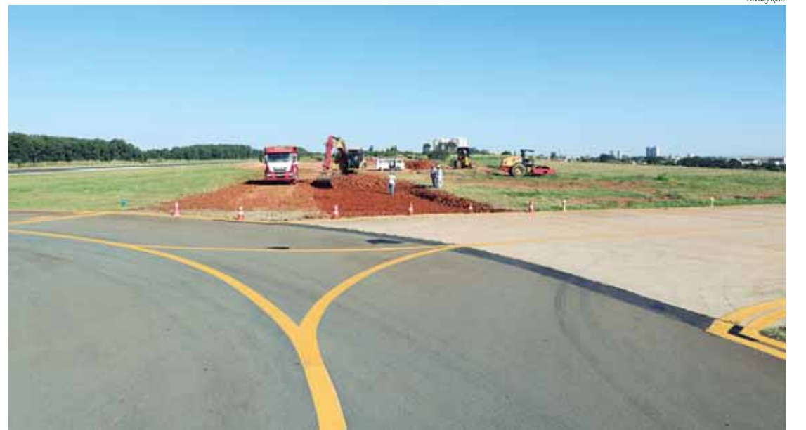
Prefeitura iniciou a obra de ampliação da pista auxiliar (taxiway) do Aeroporto Pedro Morganti
