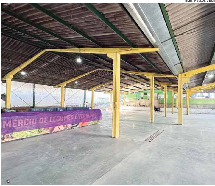
Foi realizado toda a troca do piso e reforma hidráulica
